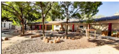
Désimperméabilisation de l'école du Nord - L'Observatoire CAUE
